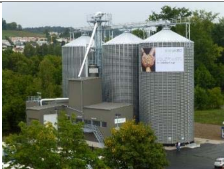
Lagersilos für Holzpellets
