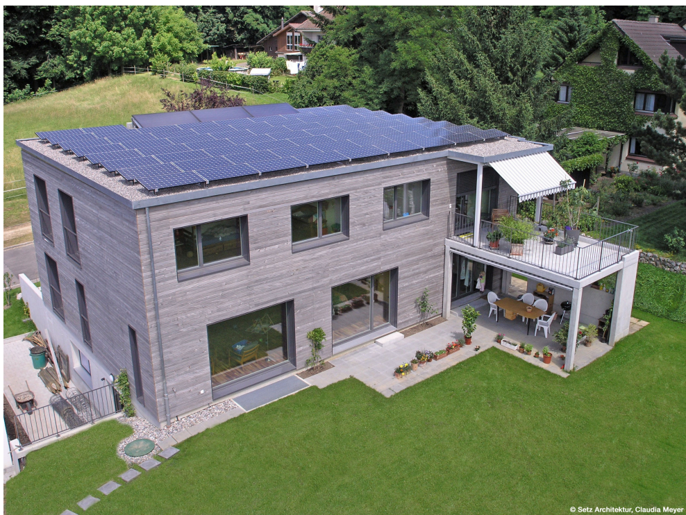
Figur 8: Die Photovoltaikanlage auf dem Plusenergiehaus in Riehen nutzt den grössten Teil des Dachs.
