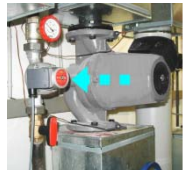
Fig. 6.1 Beispiel Heizungs-Umwälzpumpe, vorher: 450 W (Heizgruppe rechts), nachher: 25 W (gleiche Heizgruppe links). Quelle: Biral AG
