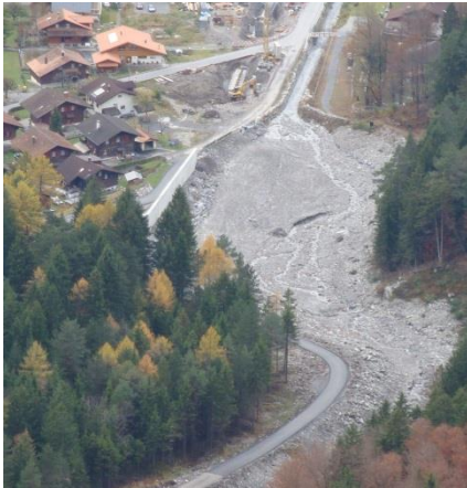
Geschiebeablagerungs- und Dosierplatz oberhalb Brienz am Glyssibach (Quelle: Mätzener & Wyss Bauingenieure AG)
