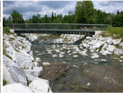
Uferverbauung und aufgelöste Blockrampe an der Pfaffnere (Quelle: Dept. Bau, Verkehr und Umwelt, Kanton Aargau)
