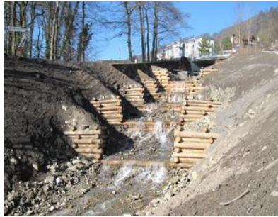
Holzsperren am Schwandbach, Sarnen OW (Quelle: belop)
