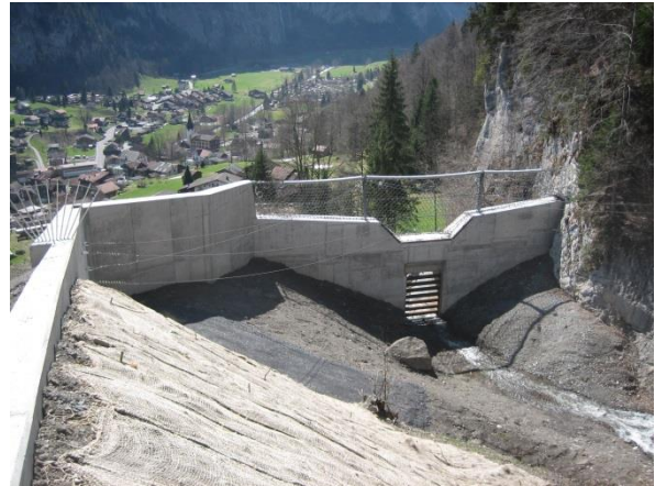
Geschiebesammler Gryfenbach BE (Quelle: GEOTEST AG)
