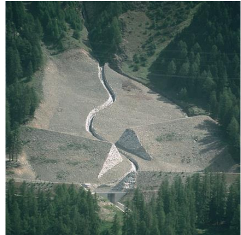
Schutzdamm Giandains, Pontresina GR (Quelle: Amt für Wald und Naturgefahren)
