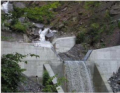
Betonierte Sperrtreppe am Milibach, Meiringen BE (Quelle: Gabriella Massimi)
