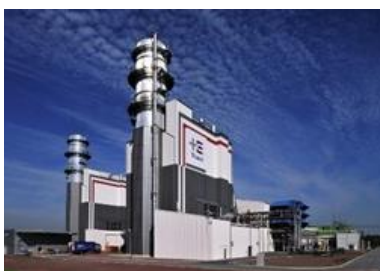
Gas- und Dampfkraftwerk Irsching (D) (Block 4) mit einer Leistung von 561 MW und einem Wirkungsgrad von 60,4 Prozent.
