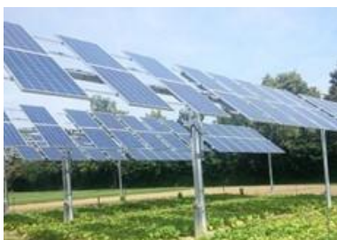
Agri-PV Fruitfarm (NL) mit einer Solarüberdachung von 32 000 m 2 Fläche und einer installierten Leistung von 4,8 MWp.
