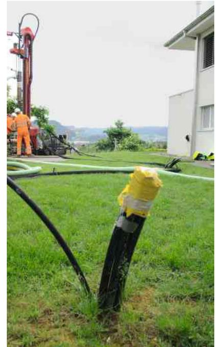
**Eine nachträgliche Realisierung von Erdwärmesonden ermöglicht einen Wechsel bei der Energieversorgung. (Bild: Jürg Wellstein)**
