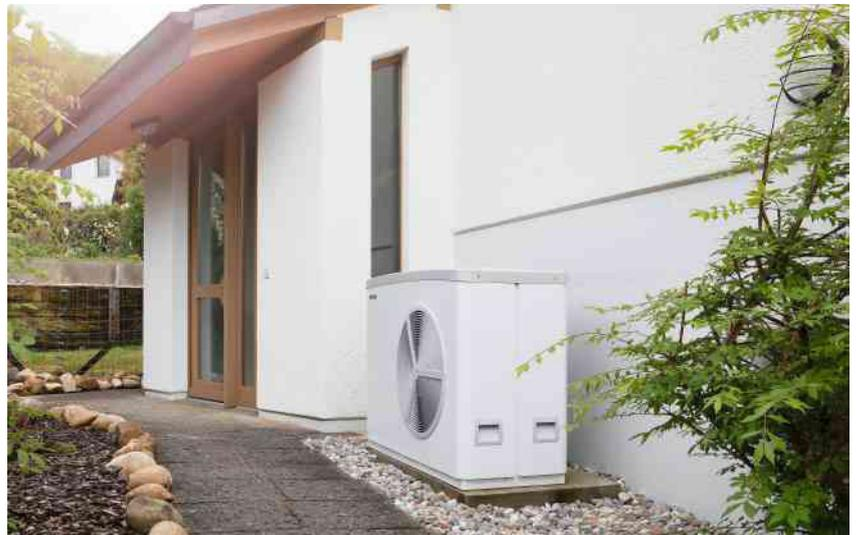
**Aussenaufgestellte Luft/Wasser-Wärmepumpe, Beispiel Stiebel Eltron WPL 25 AC: Heizen und Kühlen möglich, Vorlauftemperaturen bis 65 °C, tiefe Schallwerte, einfache Montage bzw. wenig bauliche Massnahmen (nur Stromanschluss, Vor- und Rücklauf durch Hauswand), kein Platzbedarf im Keller, energieeffiziente Inverter-Technologie. (Bild: Stiebel Eltron AG)**
