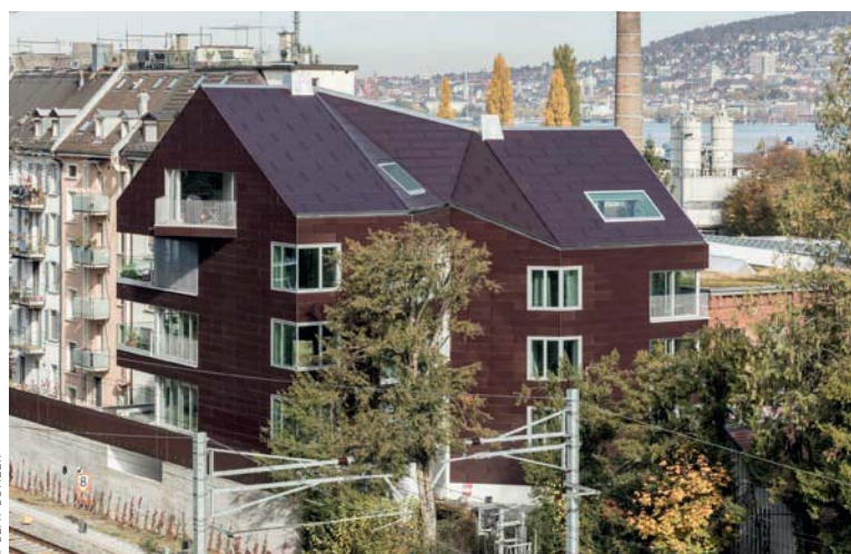
Wohnhaus «Solaris» in Zürich. 10-Familien-Haus mit 814 m 2 HNF und knapp 72 kWp installierter Leistung. Weitere Infos zu «Solaris» im Artikel ab S. 26.
